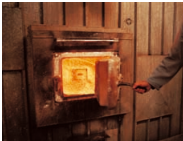
Impianto di cogenerazione presso lo stabilimento di produzione del caffè di Magonza, in Germania, dove i fondi di caffè sono utilizzati come combustibile
